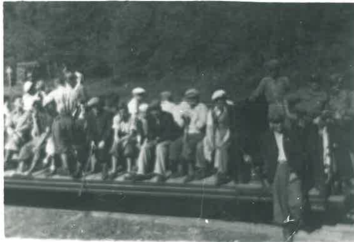
Kolejka wąskotorowa w Tatarowie Na zdjęciu wagonik-platforma, wzdłuż wagoniku, środkiem była umocowana ława z oparciem dwustronnym /pasażerowie siedzieli plecami do siebie/ W składzie pociągu był również wagonik kryty. Wagony - platformy służyły również do transportu drewna ściąganego z lesistych gór.
